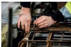
1. Installieren Sie den Kabelsensor
