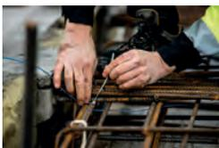
1. Installieren Sie den Kabelsensor
